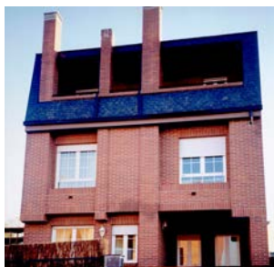
Fachada C/ Nueva Caledonia.
